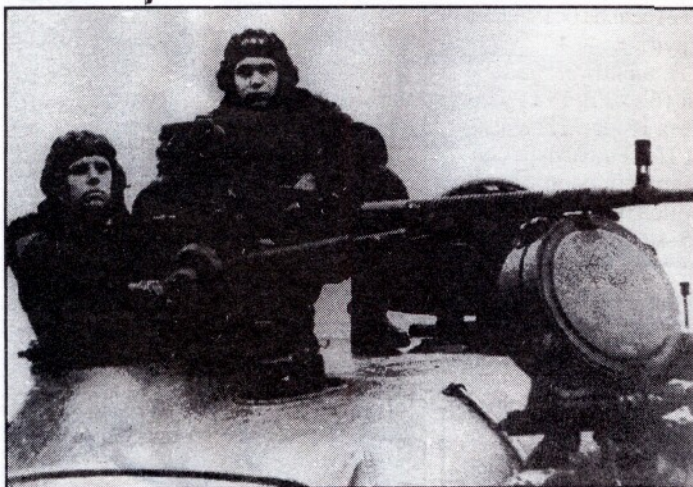
■ Танковая зенитная установка пулемета ДШК М
